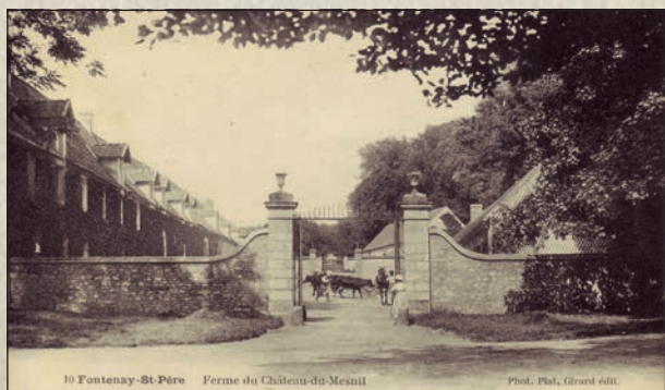
La ferme du Château du Mesnil.
